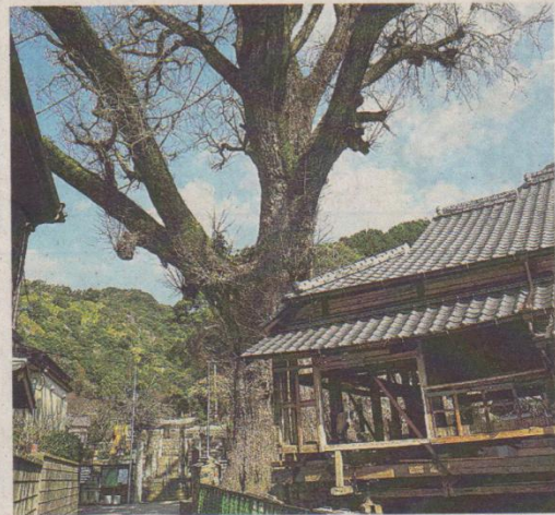
大イチョウ直下に建つ伝統的建造物の曳家中の様子
