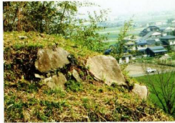
櫓台⑫南面石垣(南西より)
