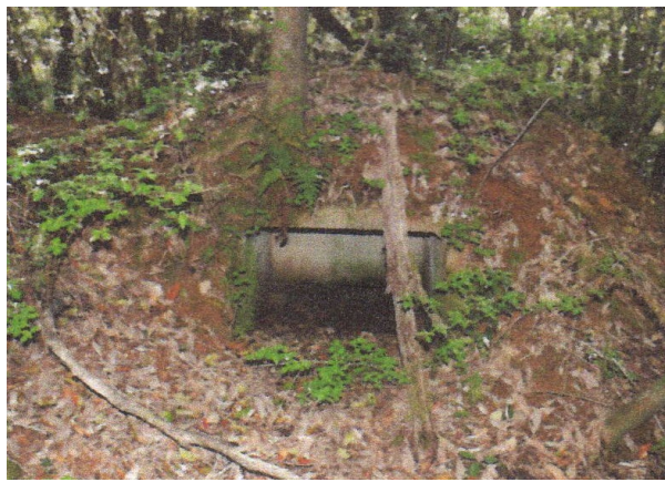
砲台跡の盛土の護壁と弾薬庫と思われる遺構
